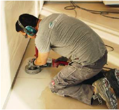
Je nach Objektgröße kommen kleine, mittlere oder große Schleifmaschinen zum Einsatz. Die Randbearbeitung erfolgt per Handschleifer.
