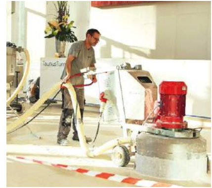
Je nach Objektgröße kommen kleine, mittlere oder große Schleifmaschinen zum Einsatz. Die Randbearbeitung erfolgt per Handschleifer.
