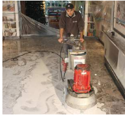
Je nach Objektgröße kommen kleine, mittlere oder große Schleifmaschinen zum Einsatz. Die Randbearbeitung erfolgt per Handschleifer.
