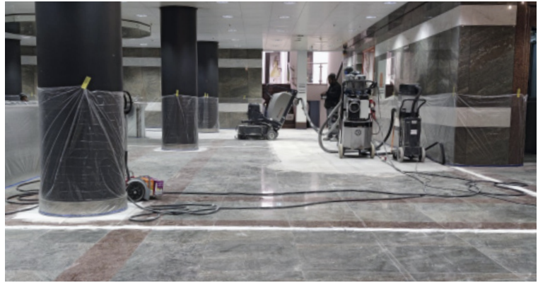
Ein Teil der sanierten Belagsfläche während der Bearbeitung
